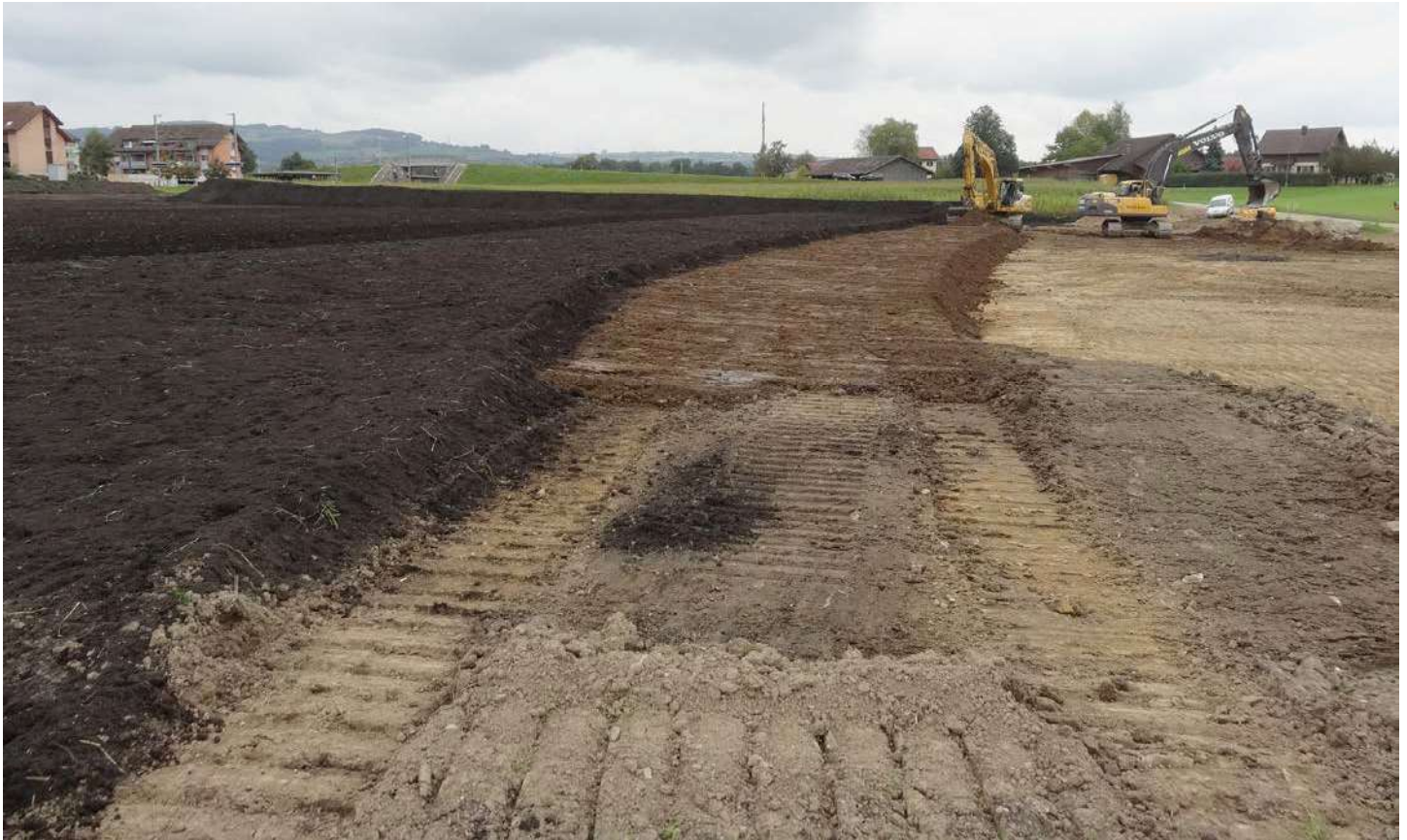
Korrekturer Aufbau eines Bodens: Untergrund (rechts), Unterboden (Bildmitte) und Oberboden (dunkelbraun) werden aufeinandergeschichtet.
