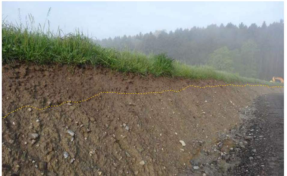
Gelungenes Beispiel einer Rekultivierung: Die gestrichelte Linie markiert die Grenze zwischen Unter- und Oberboden.
